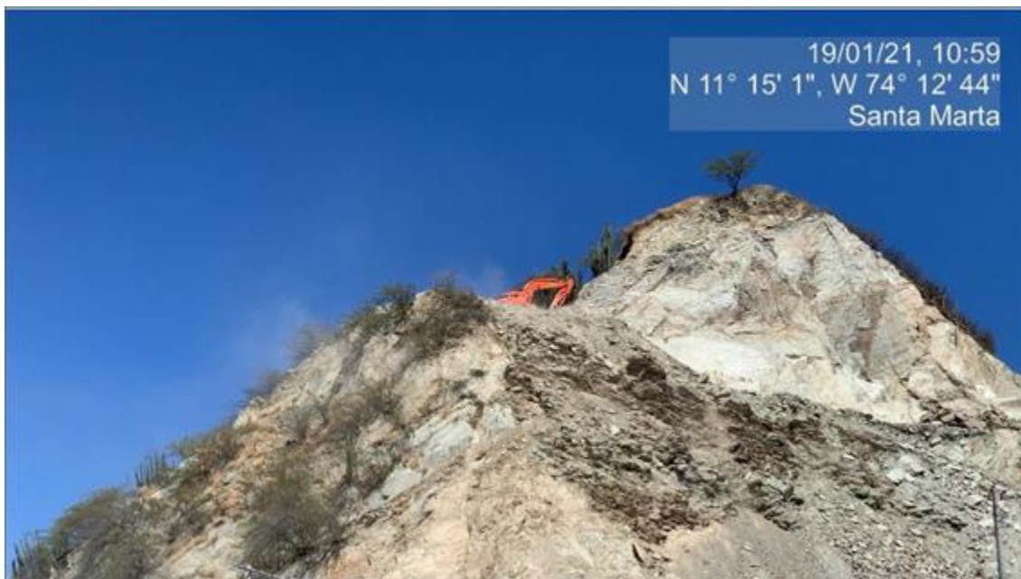
Maquinaria pesada moviendo material de cerro en inmediaciones a la SPSM
