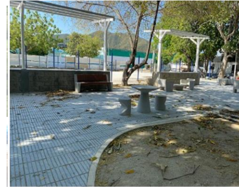
Río Manzanares - Parque lineal 1ra etapa 7054 m2 sobre ronda hídrica 711 m con estructura de protección contra erosión en distintos puntos del cauce
