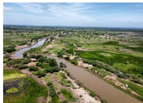
Caño Renegado 10 km remoción de sedimentos
