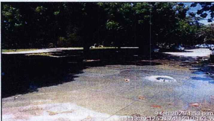
Imagen 1. Rebosamiento de agua residual en pozo de inspección de la red de alcantarillado sanitario.
