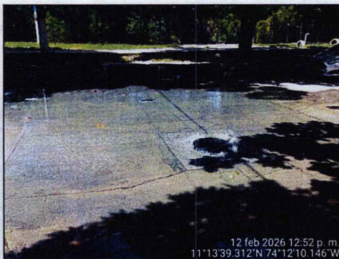
Imagen 4. Rebosamiento de agua residual en pozo de inspección y vertimiento en el río Manzanares.
