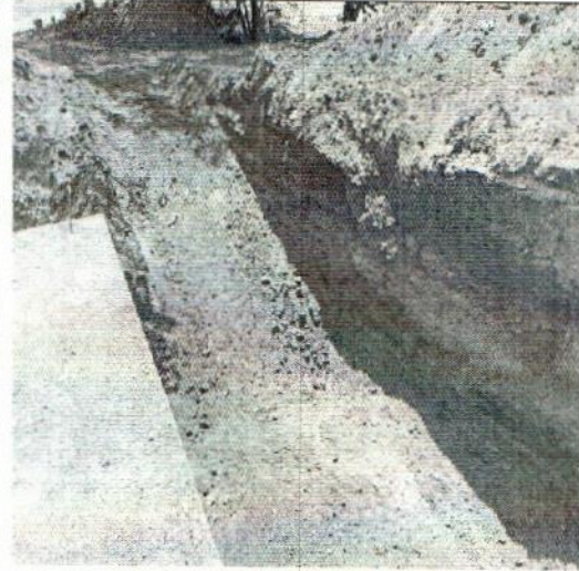
En la imagen se observa las excavaciones realizadas dentro de la quebrada
