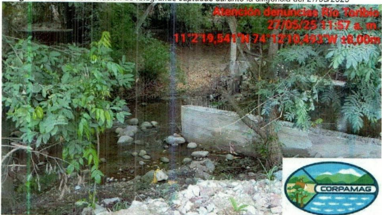
Construcción de muro en concreto sobre el cauce del Río Toribio – Vista frontal de obstrucción parcial del flujo hídrico
