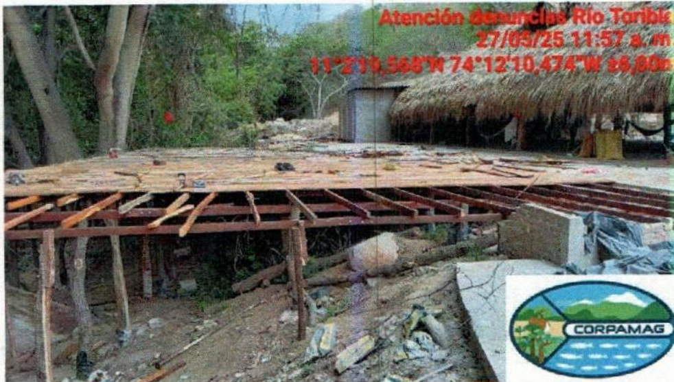
Avance de plataforma en madera con vista hacia zona de cabañas – intervención contigua al cauce del Río Toribio
