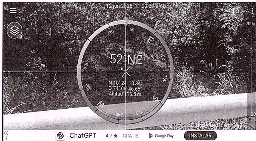
FOTO 3. Toma georreferenciada desde la estructura del puente (Vista Nororiente)
