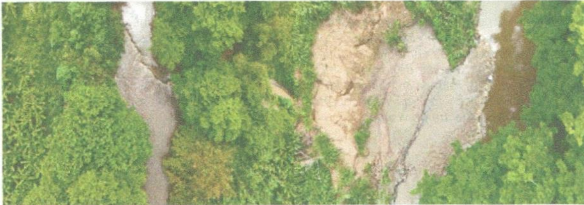
Trincho Predio Don Euar 1
