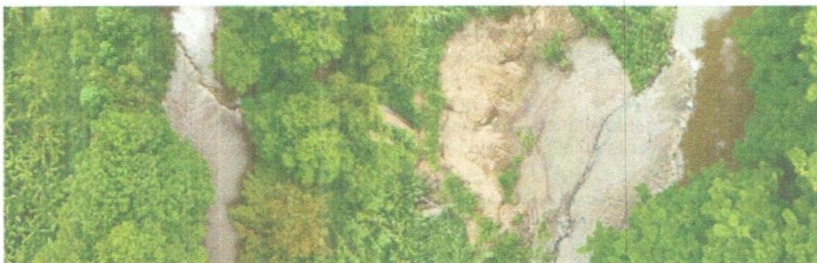
Trincho Predio Don Fuad 1
