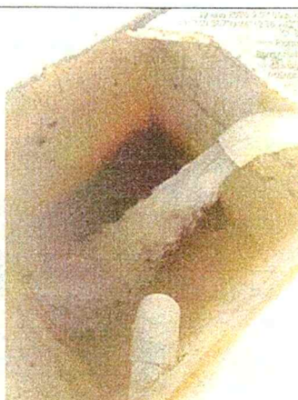
Imagen 3. Registro donde llegan las aguas captadas de comparten entre 2 o hasta 3 pozos.
