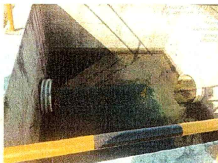
Imagen 4. Piscina de muestreo donde se acopia toda el agua extraída de los pozos y es el punto donde se toma el muestreo.
