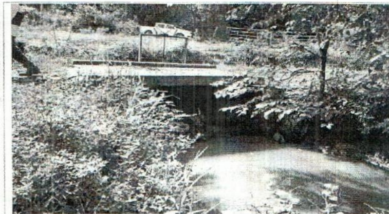
Foto3. Derivación del Canal "Gutiérrez" y estructura de control de caudal en punto de coordenadas 10°32'0.29"N - 74°14'21.08"O
