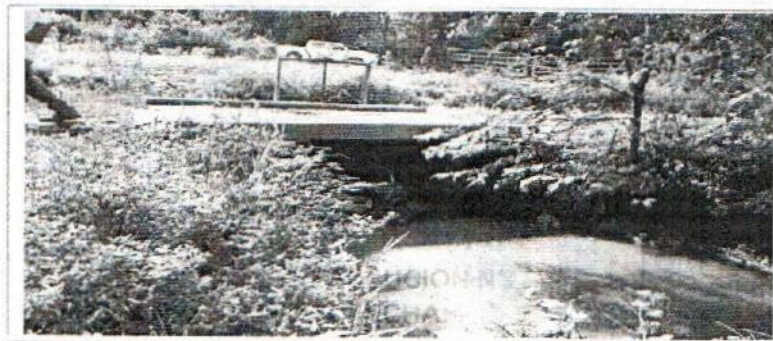
Foto3. Derivación del Canal "Gutiérrez" y estructura de control de caudal en punto de coordenadas 10°32'0.29"N - 74°14'21.08"O
