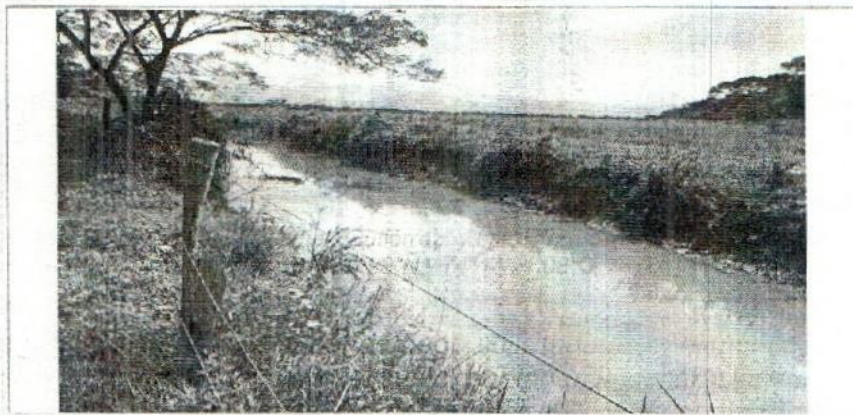
Foto2. Canal no revestido usado como estructura de conducción
