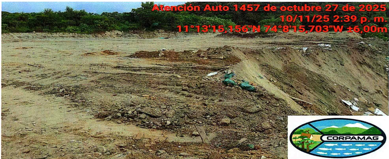
Foto 7. Zona de disposición nivelada en la parte baja del predio, utilizada para la recepción inicial de materiales.
