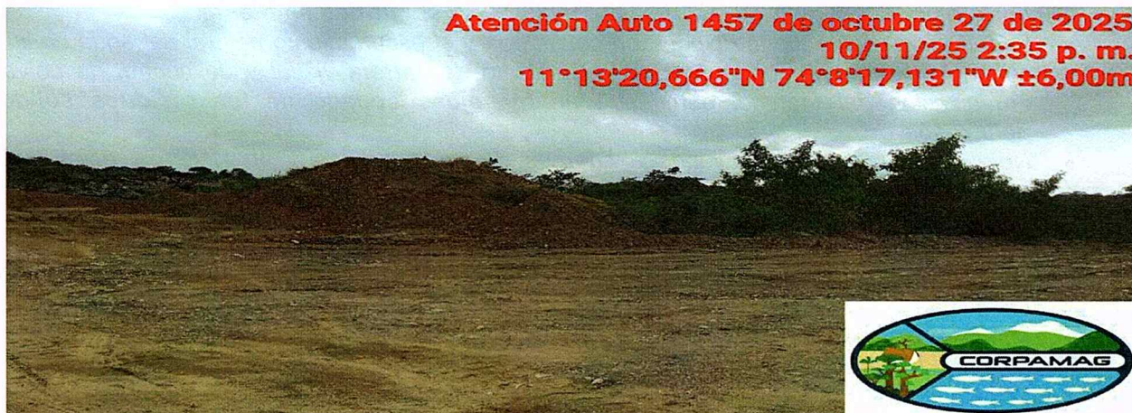
Foto 2. Área de acopio temporal de material granular y suelo producto de nivelaciones internas.
