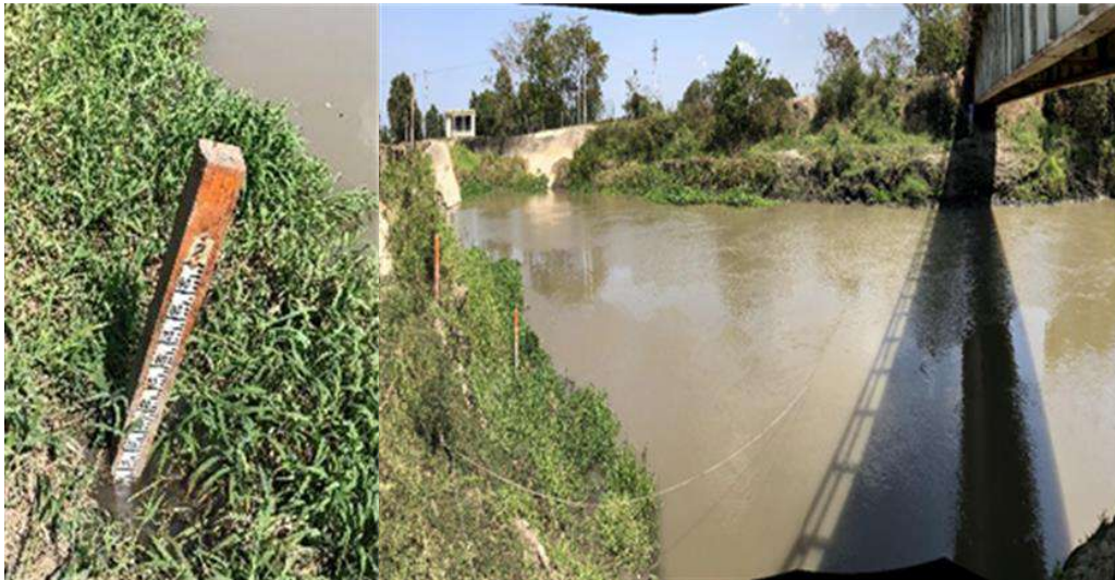
Figura 15. Condición caño Aguas Negras en febrero de 2020.
