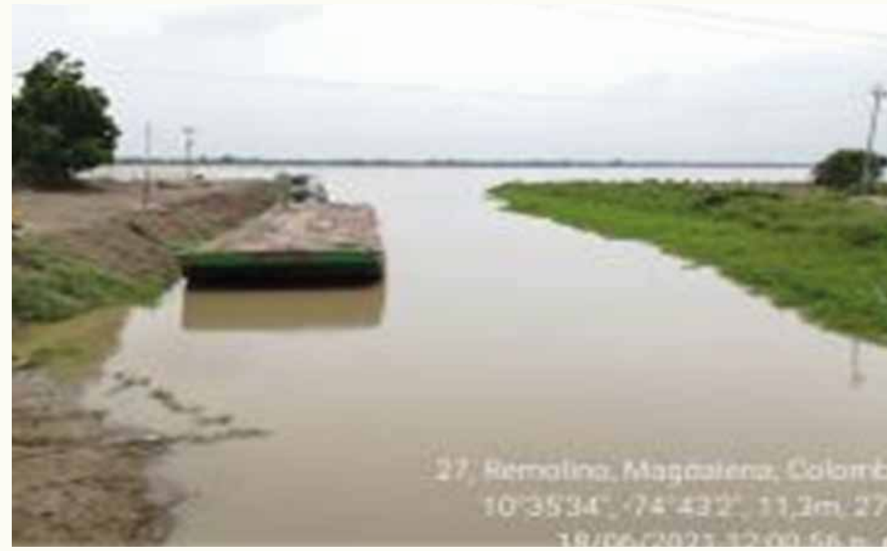
Estado del Caño Renegado, después de intervención en sector embocadura.
