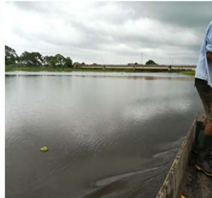
Vista después de la intervención
