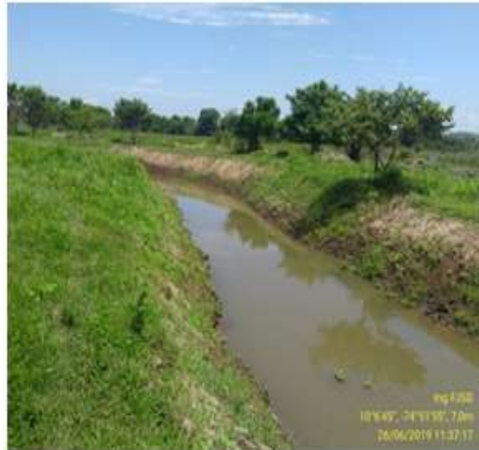
Vista después de la intervención
