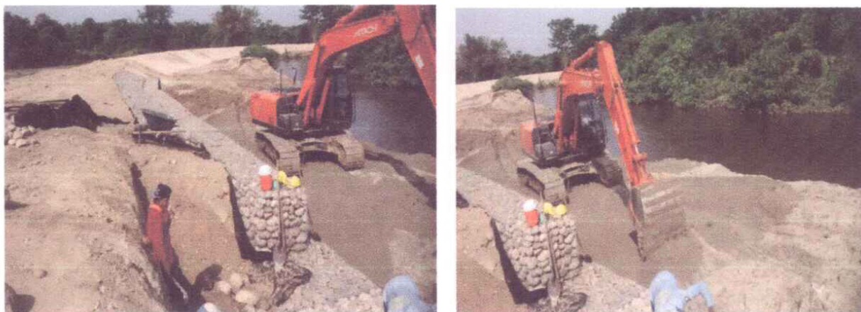
Construcción de gaviones en garrapata 1
