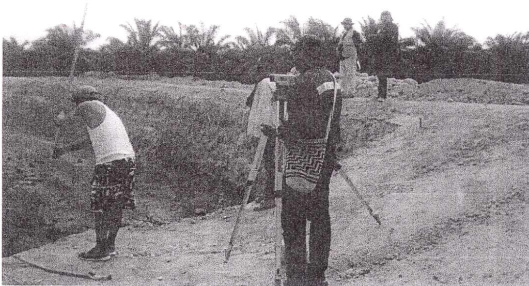
Labores de nivelación para emplazamiento de Gaviones
