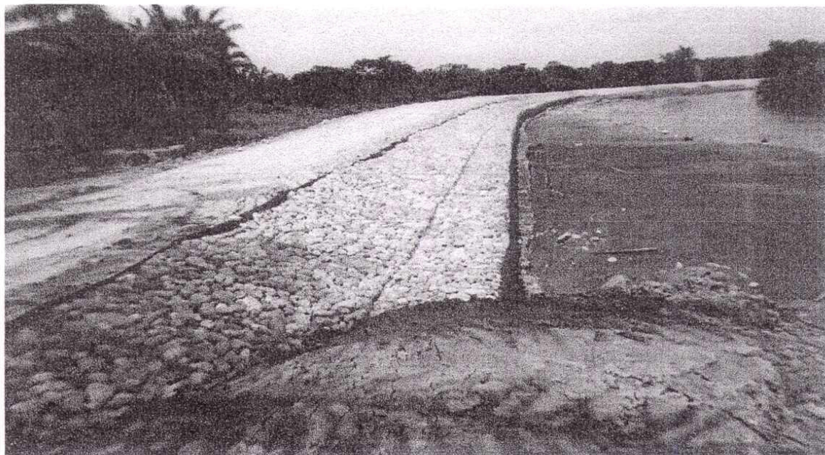
Gaviones Conformados en Garrapata 1
