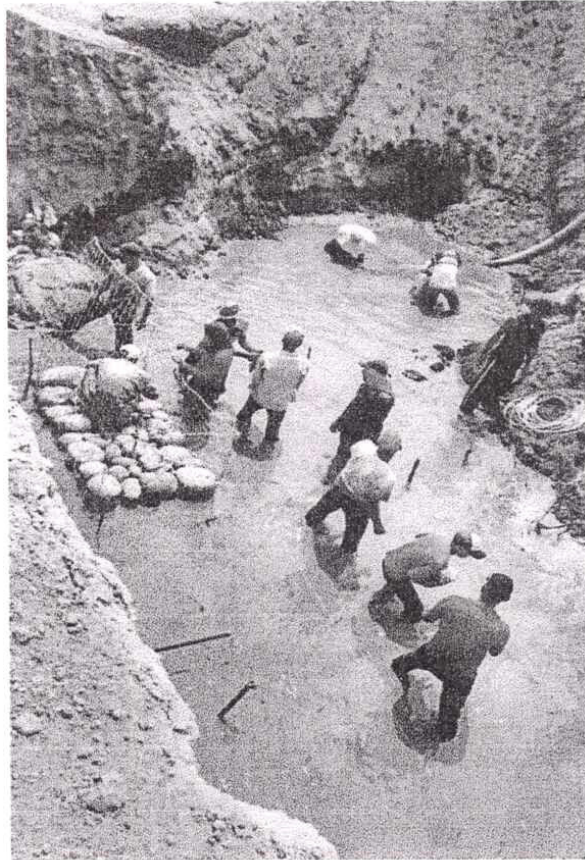
Armado de Gaviones en rompedero de garrapata 1
