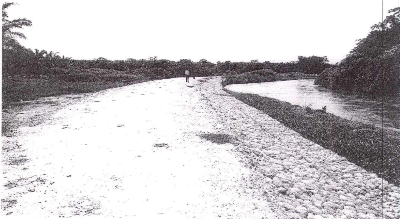
25 noviembre de 2016. Estado del dique, vista sur hacia Garrapata 1
