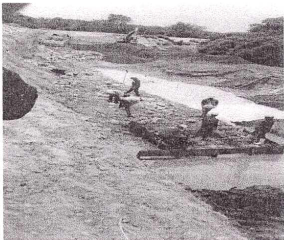
Armado de gaviones en Garrapata 1
