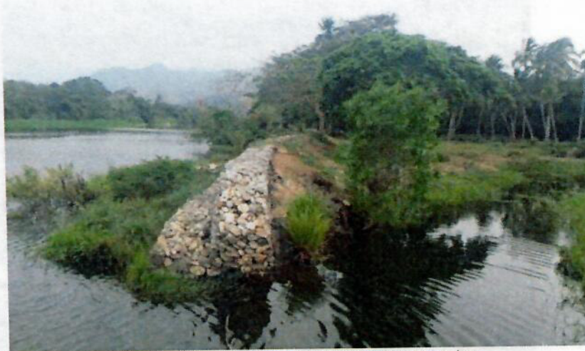
Ilustración 15. Obras de protección actuales.
