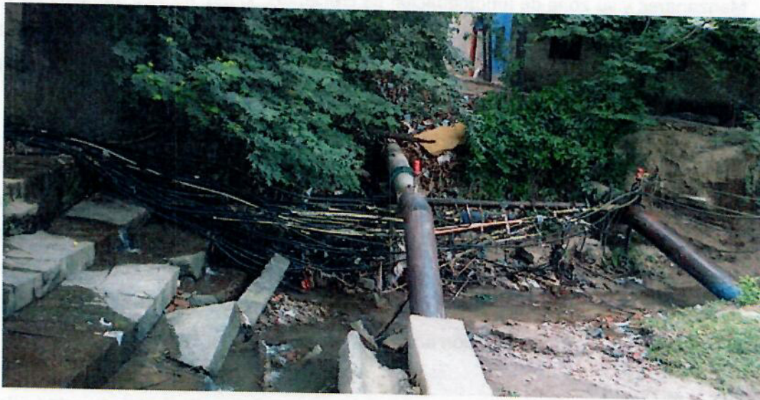
Ilustración 13. Redes y viviendas ocupando ronda del río Manzanares. Fuente: Propia
