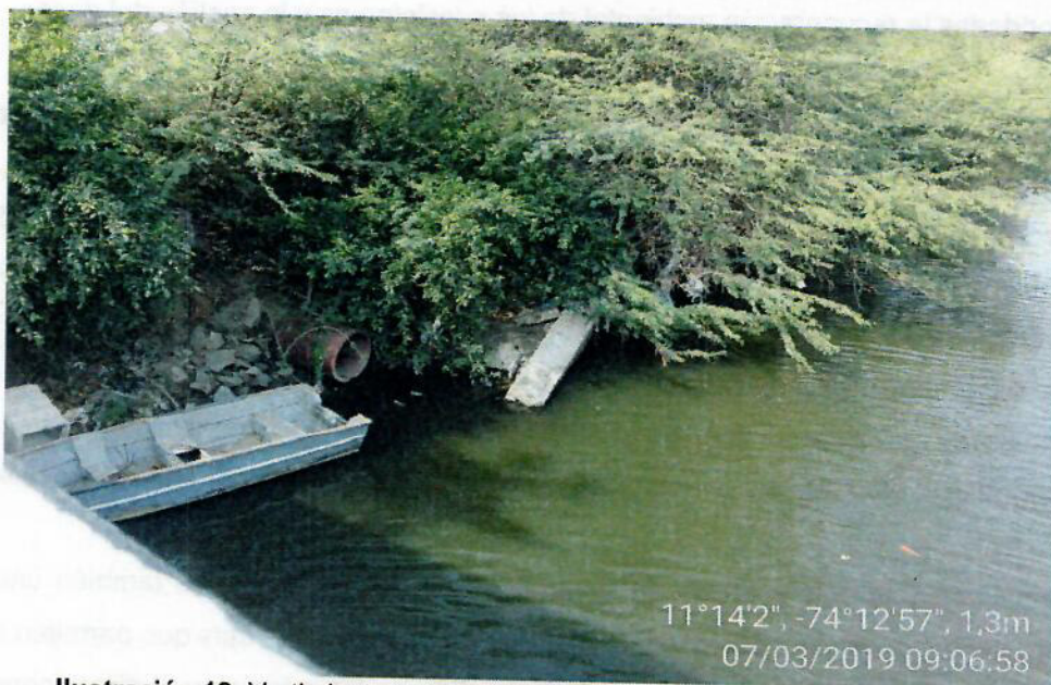
Ilustración 12. Vertimientos en el río Manzanares por parte de la comunidad.
