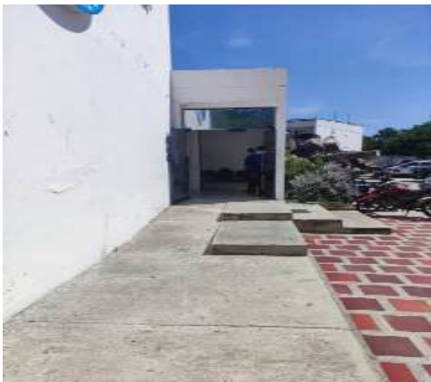
Rampa de medidas 1.25 cm de ancho e inclinación del 5%
