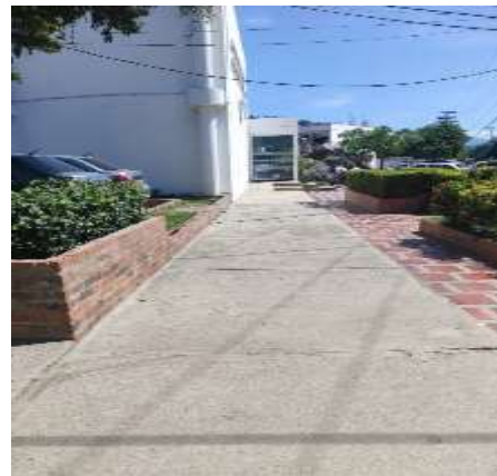
Piso entrada principal antideslizante elaborado en concreto
